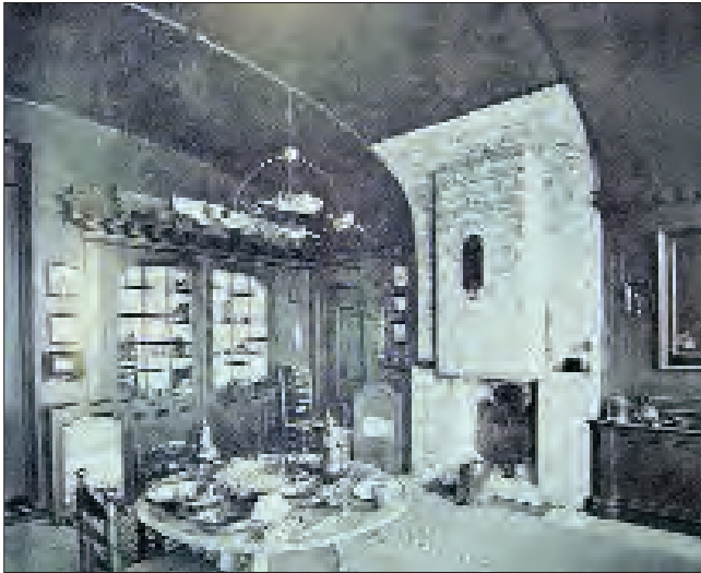
Abb. 11: Wo die Fliesen angebracht waren.
